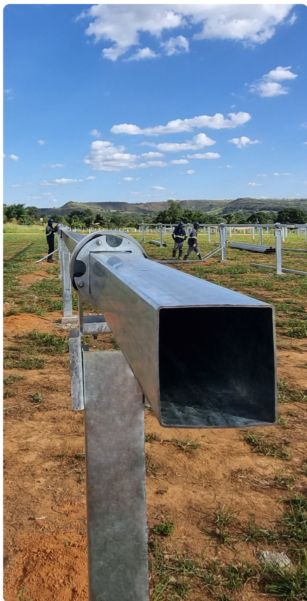
Tubos estruturais quadrados Tuper, 100x100 mm, aplicados em usina de geração de energia distribuída.
